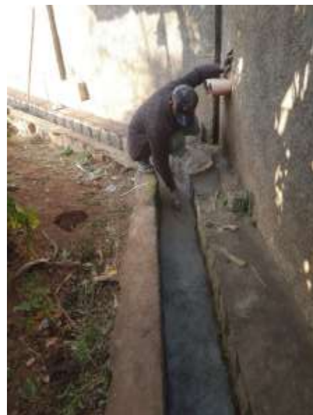
Rénovation des écoulements d'eaux pluviales par Nirina
